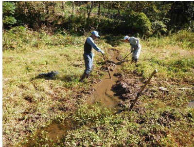
土水路の造成
